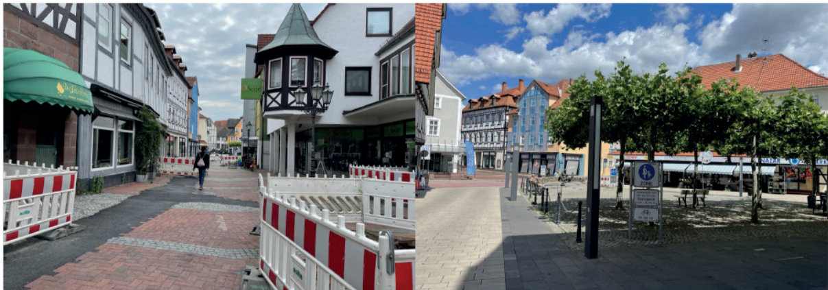
Uneinheitliche Untergrundgestaltung und Baustellen
