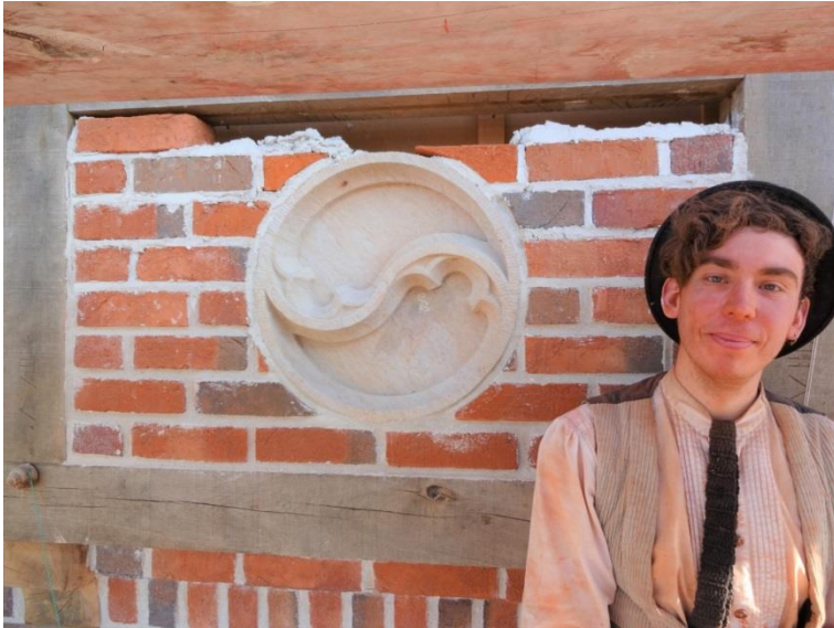
Auf der Baustelle beim Versetzen eines gehauenen Maßwerkes bei Schwerin
