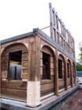
Endlich ging es auf der Baustelle an das Aufstellen der Blockstube. Das besondere an diesem Umgebindehaus ist, dass es aus zwei Blockstuben besteht und kein Stallwohnhaus ist. Da der Bauherr keinen Kran zur Verfügung stellte, mussten wir die teilweise 16/30 cm starken und 8 m langen
