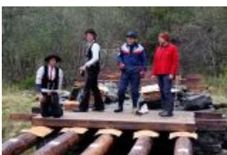
Auf den Bildern sieht man die technischen Besonderheiten aus dem alten norwegischen Brückenbau wie z.B. die mit Holzkohlenteeröl eingepichteten Zapfenverbindungen oder das waagerechte Rundholz welches mit Bikenrinde als Holzschutz abgedeckt wurde.
