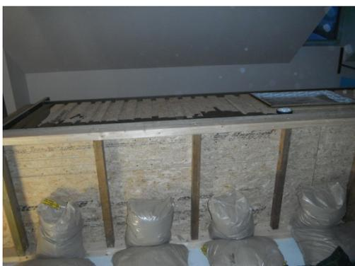
nicht im Boden verankert werden konnte in Beton zu gießen, hatte bis dato von uns dreien noch keiner gemacht. So wurden zunächst die Unterschränke mit einer Konstruktion aus OSB versehen und dann dort herum eine ausgeklügelte Schalung aus glatter Spanplatte und Kanthölzern gebaut. Keiner wusste genau wie sich die Konstruktion, die nur mit Sandsäcken beschwert wurde und teilweise ausgekeilt war, unter dem enormen Druck des Betons verhalten würde. Leider nicht gut, da
