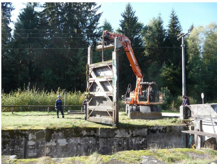
Die Tore bestehen aus einer Fachwerkkonstruktion, die mithilfe von Eisenteilen gehalten und befestigt werden. Ein Belag aus Eichenbohlen hindert das Wasser am Durchdringen der Tore. Anhand der alten Tore sollte eine Nachbildung entstehen. Die Holzteile wurden vollständig erneuert. Überarbeitet erhalten bleiben konnten die alten Eisenteile wie Winkel, Zugstreben, Fußhaltepunkte, die oberen Torhalterungen und die Laufsteghalter.
