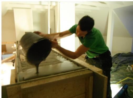
Das Problem löste sich zum Glück schnell von selbst, als der schnell abbindende Beton die Löcher verschloss. Nachdem jedoch der restliche Beton eingefüllt war und die Schalung nach wenigen Stunden abgenommen wurde zeigte sich die Unterbrechung in einer langen Horizontalfuge an der Rückwand des Blocks. Zudem war die Kante der Frontseite wellig und die Oberfläche der Arbeitsfläche ließ zu wünschen übrig. Also beschloss Kam. Krause die wellige Kante mühselig einzuflexen und sie, wie die Oberfläche
