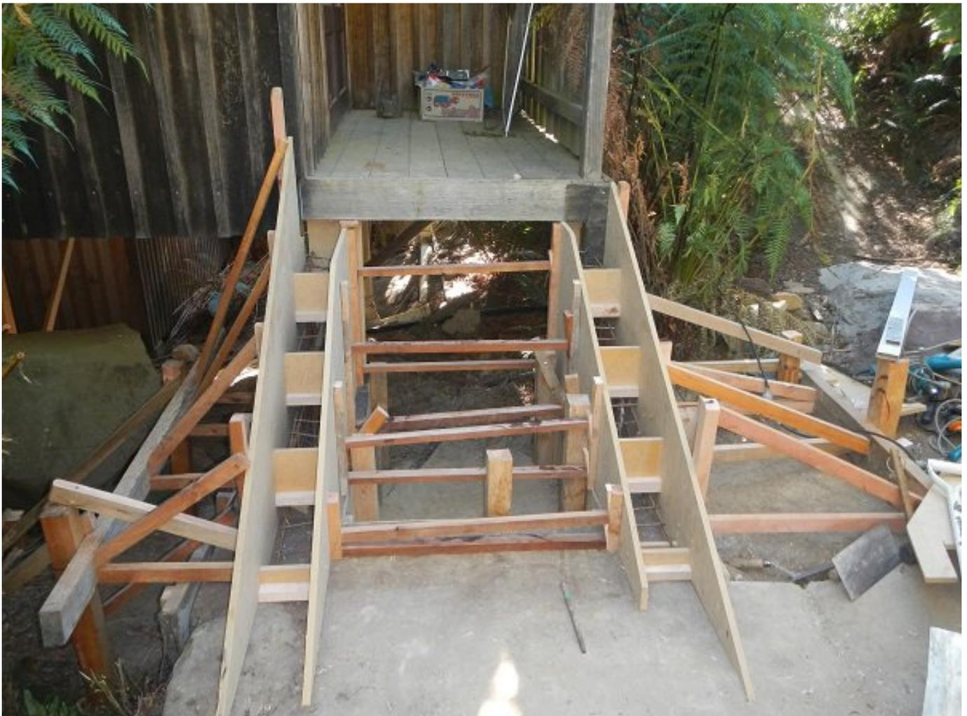
Die Treppenstufen wurden separat in Formen gegossen und später auf die fertigen Wangen aufgelegt, wie geplant waren wir am Freitag mit dem Projekt fertig.
