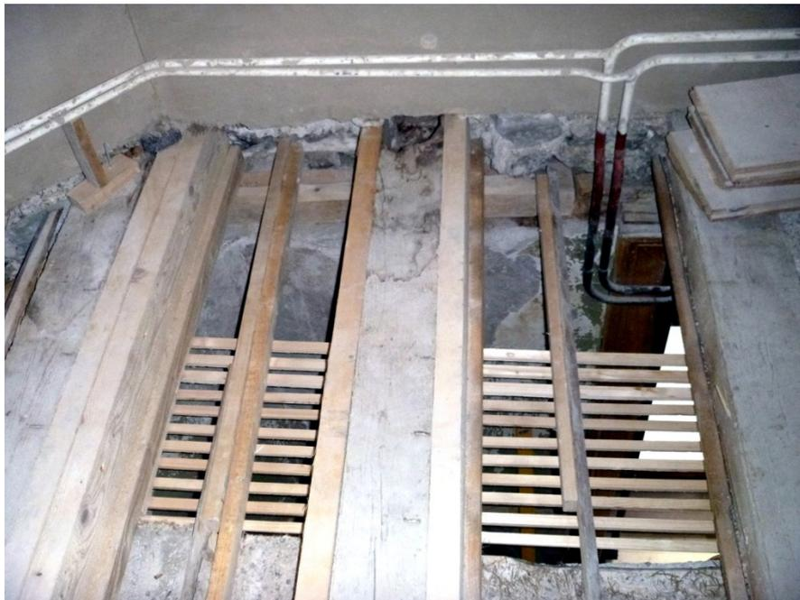
Dann verputzte ich am übernächsten Tag die Decke, von der Seite des Saals, nachdem ich das durchhängende Stroh abgekratzt hatte eine Kalksandmilch (Patschuk) auf die Latten strich. Durch dieses Vorgehen werden ein freskales Abbinden und ein exzellenter Verbund der beiden Schichten garantiert.
