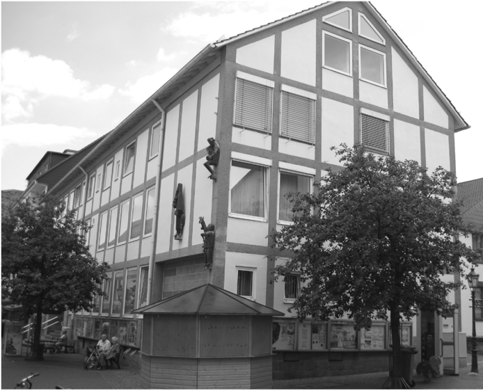
Das Haus Johannesstraße, Ecke Mühlenstraße im Jahr 2008
