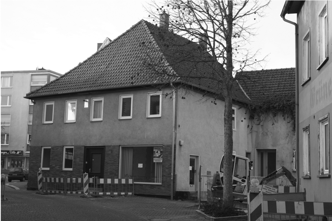
Haus Petristraße 1 kurz vor dem Abriss 2008
