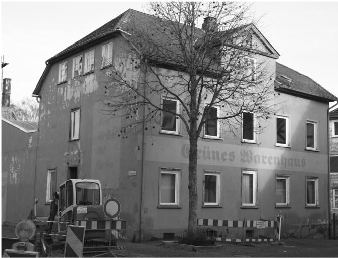
Haus Petristraße 3 vor dem Abriss 2008
