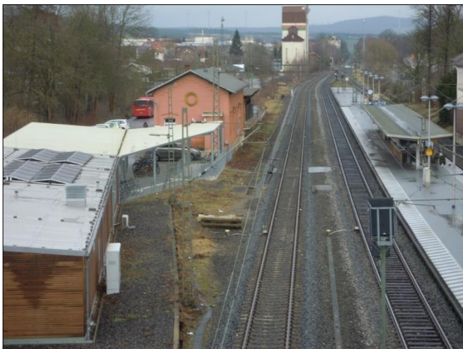
Abbildung 6 DB Strecke 2550 am Plangebiet „Industriestraße“ (Foto: GeräuscheRechner)
