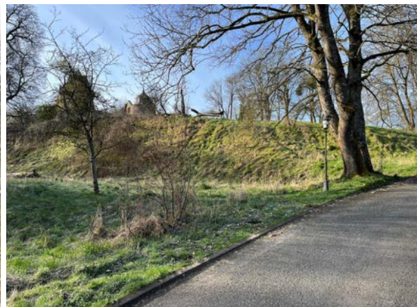
Abbildung 3: Böschungskante unterhalb des Parkplatzes (Eigene Aufnahme LBIH)
